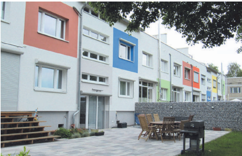
Hohenmölsen: ehemaliges Landratsamt, teilrück- und umgebaut zu Reihenhäusern
