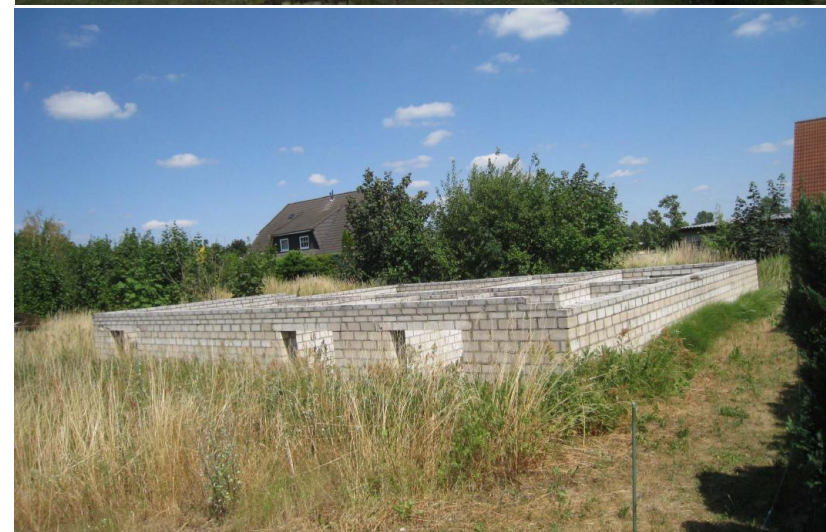
Investruine in Oebisfelde (15 km östlich von Wolfsburg)
